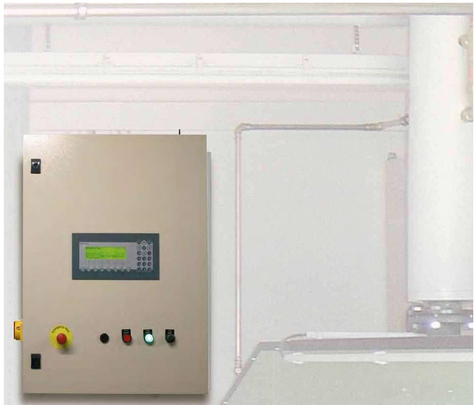
Im Schaltschrank werden alle Komponenten der Anlage mit der elektronischen SPS-Steuerung geregelt. Aktuelle Zustände der Heizanlage werden auf einem beleuchteten Display angezeigt.
