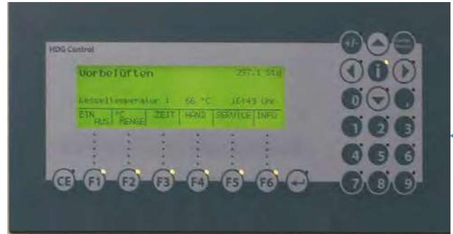
Das übersichtliche Bedienfeld der SPS-Steuerung zeigt den aktuellen Betriebszustand an und ermöglicht jederzeit die Abfrage aller notwendigen Betriebsdaten.
